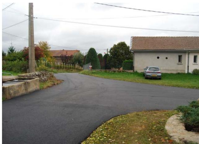
En 2011 les réfections de chaussée ont été exécutées sur la route du Villard sur une longueur de 585 mètres et sur le chemin d'Egarande à Viviers. Sur ce tronçon les entreprises ont enlevé les grosses pierres du talus amont afin d'élargir et consolider la voie et combler avec ce remblai les parties fragilisées. Les travaux de réfection de cette voie ont été faits sur une longueur de 1210 mètres avec une largeur de voie de 3,20 mètres. Le montant total de ces travaux s'élève à **123935,52€ TTC**.
